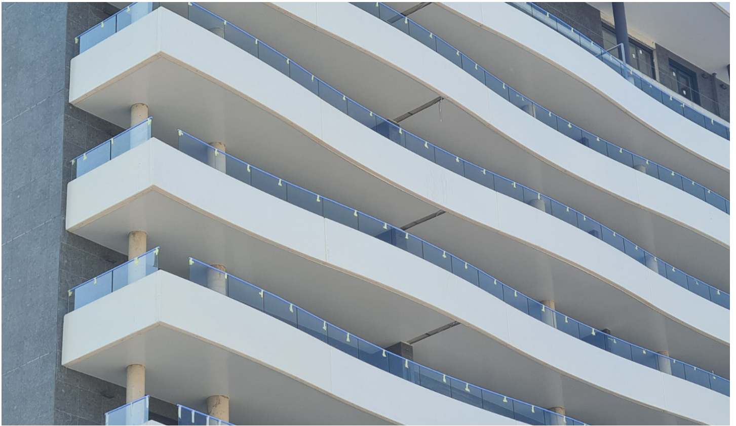
↳ Bajo balcones recubiertos con Perfil Cuvertec liso, edificio pisos de alta calidad, zona centrica de Zaragoza
