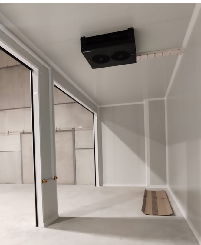
↳ Instalación de techos y paredes, cantoneras, esquineras, perfiles y zócalos sanitarios en sala
